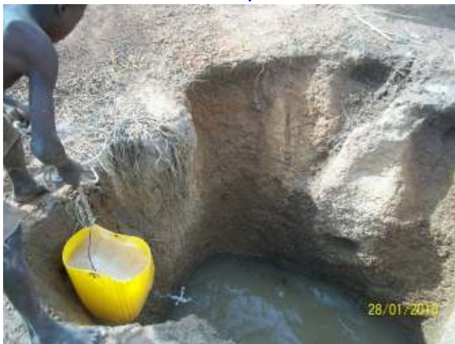
Photo 4 : Exhaure de l'eau d'un puis maraicher
