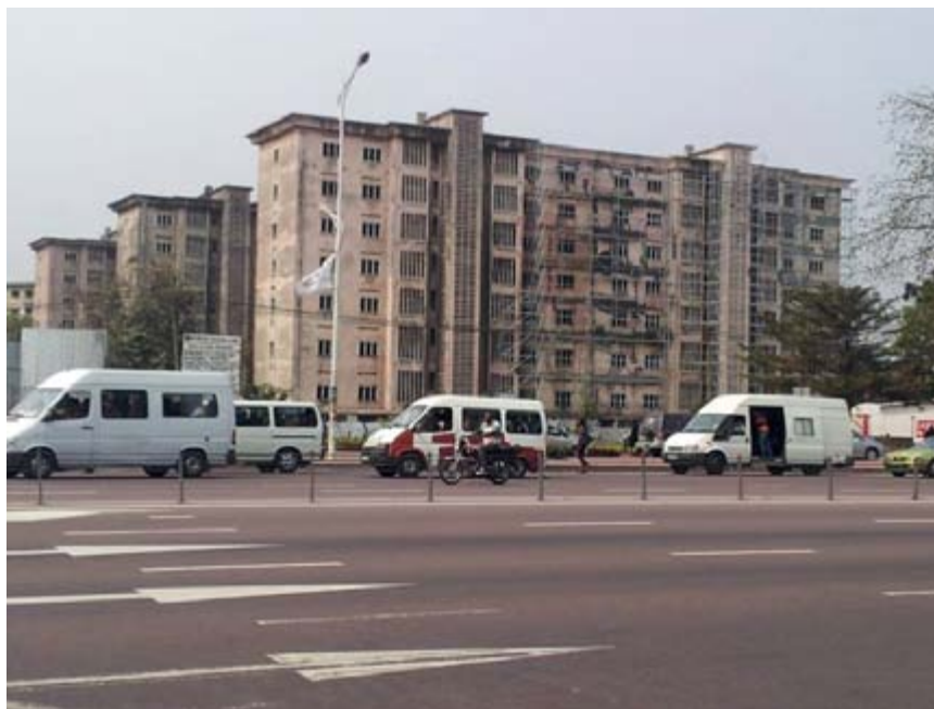
Photo 5. L'Immeuble Royal est un complexe immobilier bien connu à Gombé dans la banlieue de Kinshasa, qui a été construit dans les années 1950. Autrefois le siège des Nations Unies en RDC, il était occupé en 2013 essentiellement par des locataires, la majorité d'entre eux étant, apparemment, en sous-location à des tarifs « abordables ». 52
